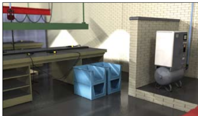
Il GA WorkPlace, con il suo funzionamento silenzioso e le sue attrezzature integrate per il trattamento dell'aria e della condensa, può essere installato direttamente nella postazione d'uso. Tale integrazione consente di risparmiare spazio e di ridurre il costo delle tubazioni.
